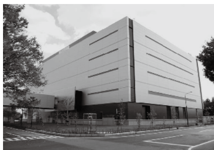
館林データセンター
