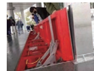
起伏式ゲート
