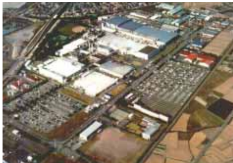
会津若松工場においてCO 2 排出量を約15%削減
