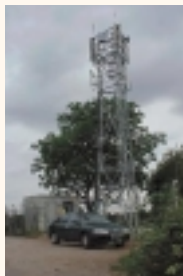
英国でフィールドトライアルを完了したIMT2000対応の基地局
