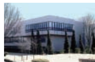
館林システムセンター
